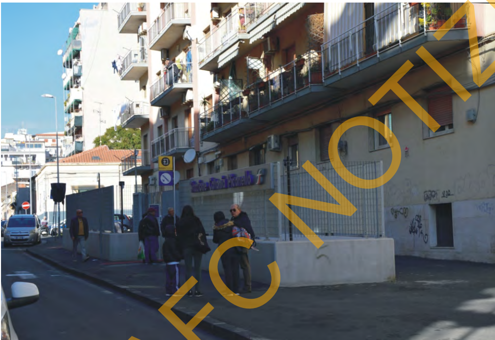
Fermata Catania Picanello esterno da Via Timoleone.
