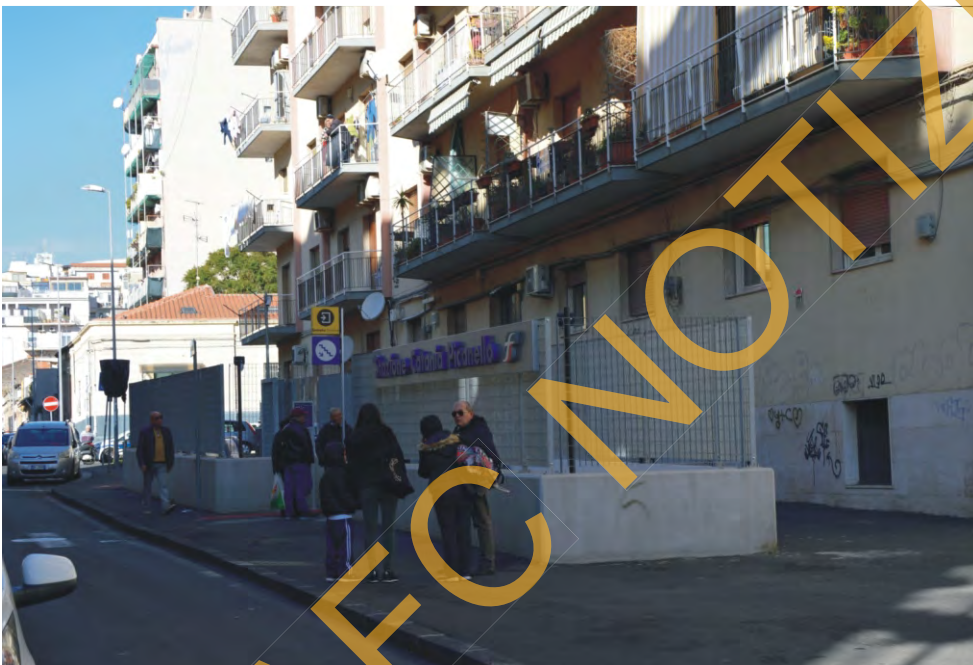
Fermata Catania Picanello esterno da Via Timoleone.
